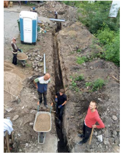
Leitungsbau, PLATZprojekt Hannover © Svenja Stahlhut
