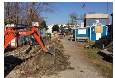
Strom-, Wasser- und Internetleitungen verlegen
