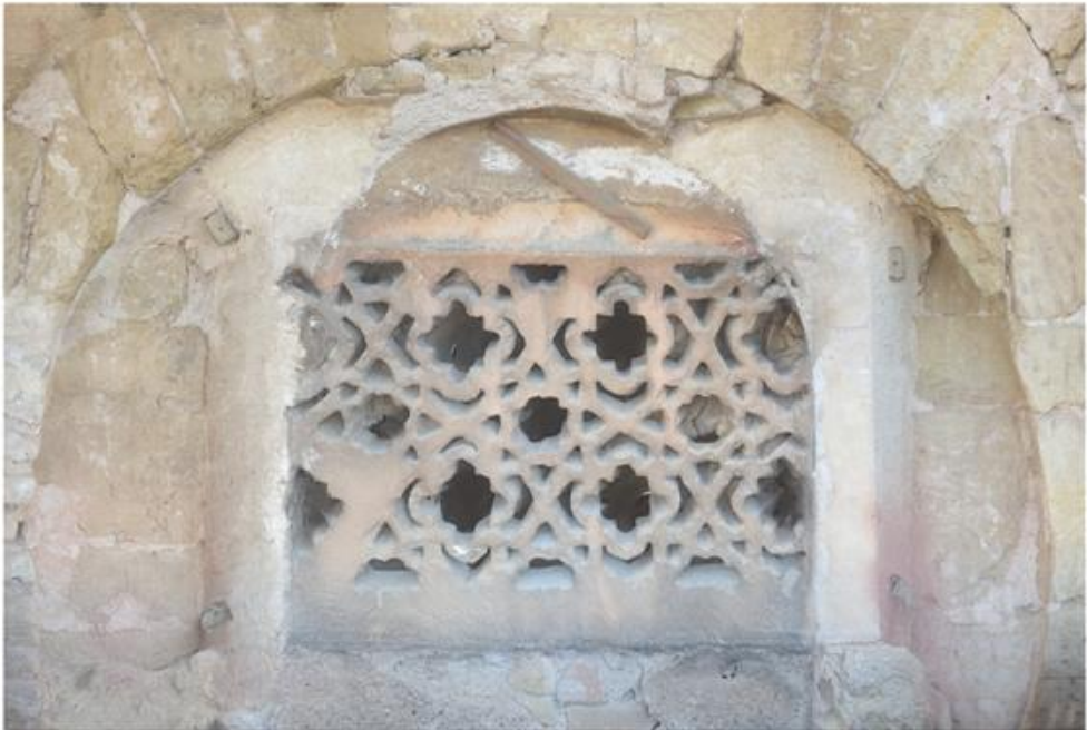
Figura 11. Celosías islámicas recolocadas en la linterna oeste de la macsura
