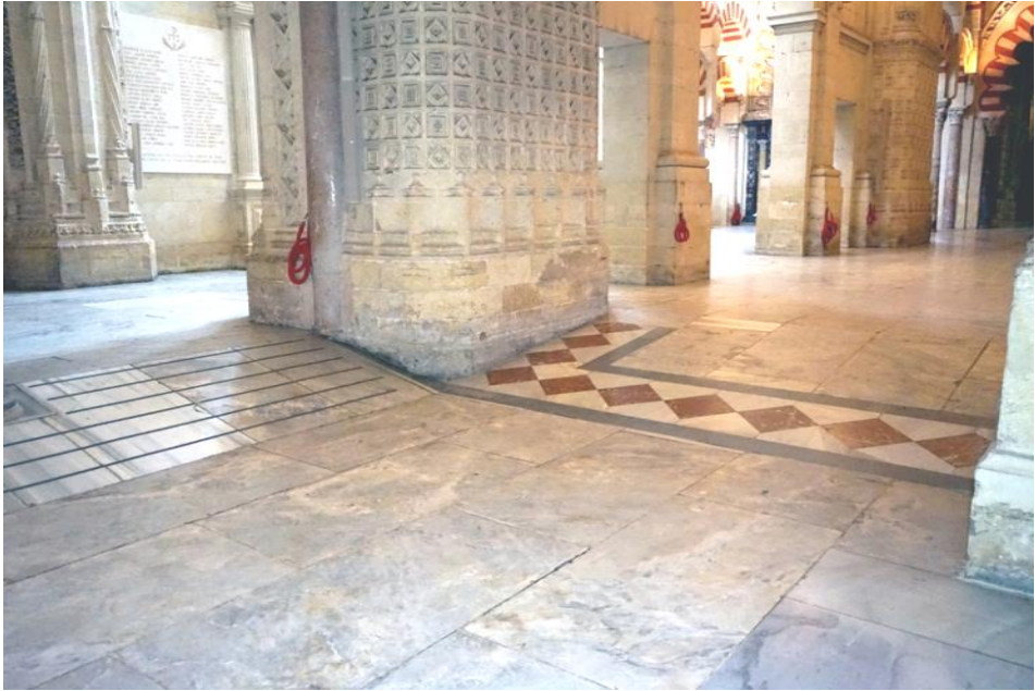
Figura 10. Cenefa de cuadrados rojos entre listeles grises en el pavimento de la Mezquita-Catedral, marcando la situación del muro sur de ‘Abd al-Raḥmān I, y el saliente exterior del mihrab
