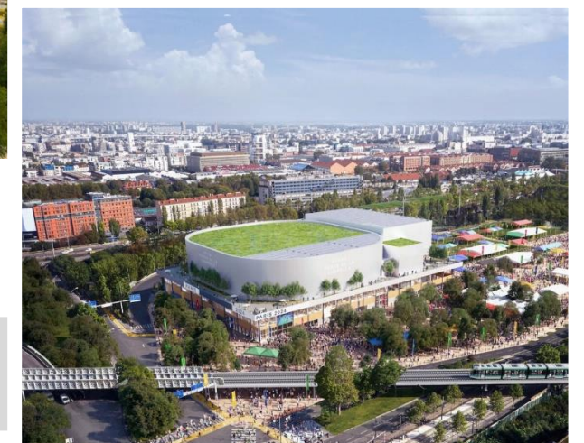
右图：羽毛球和体操 奥运比赛场馆 Adidas Arena
