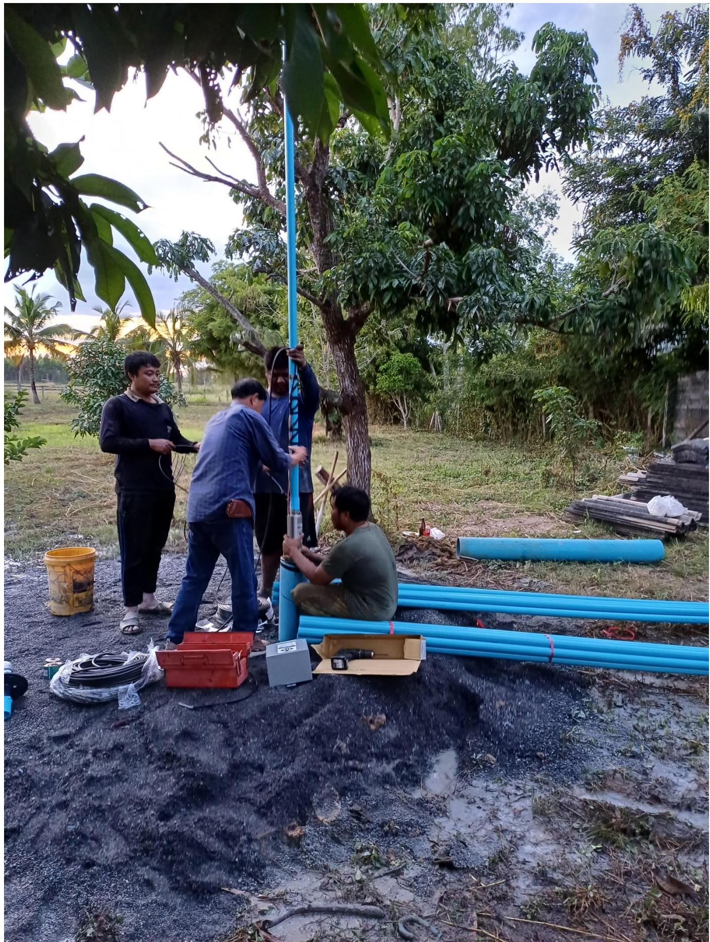
Dompelpomp gaat naar beneden / Submersible pump goes down / Tauchpumpe wird abgestellt
