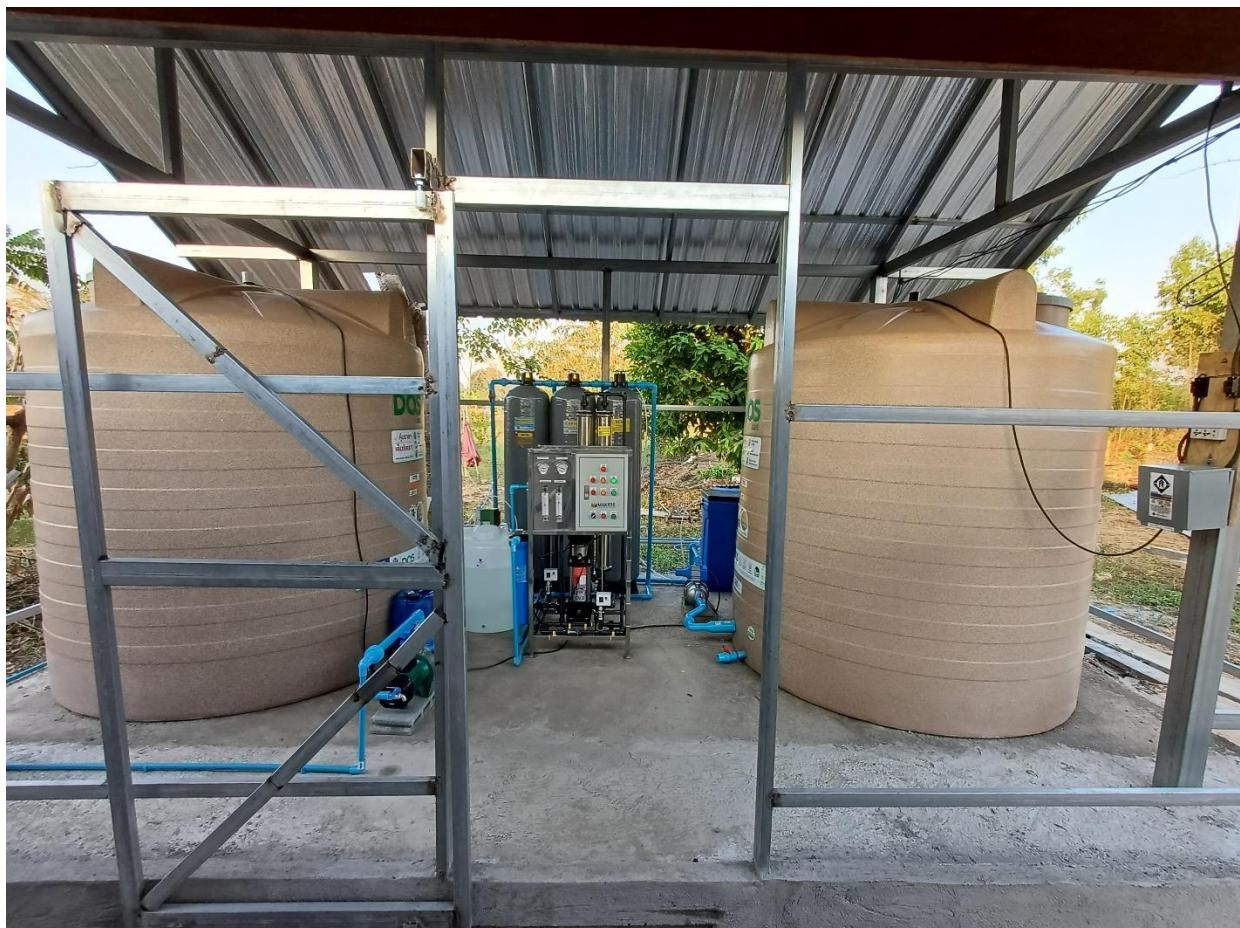
Voorfiltratie en RO-systeem / Pre-filtration and RO-system / Vorfiltrierung und Umkehrosmosesystem (RO)
