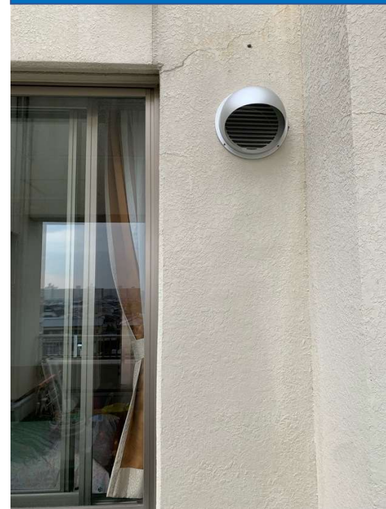
外構施工状況
