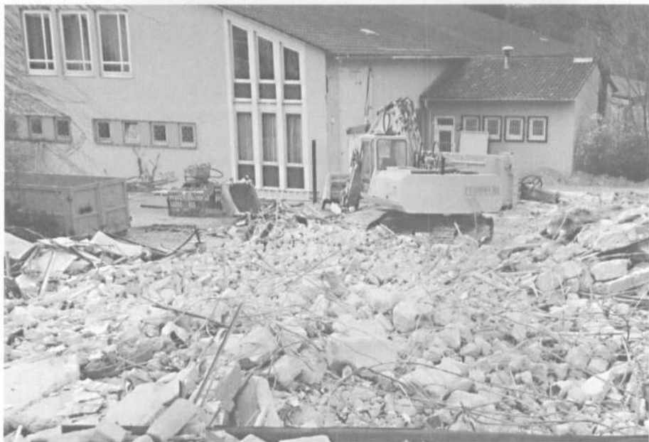
Die Trümmer der alten Gymnastikhalle - der Neubau der Sporthalle kann beginnen
