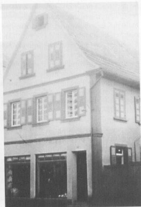
Einbau des ersten Ladengeschäftes 1957
