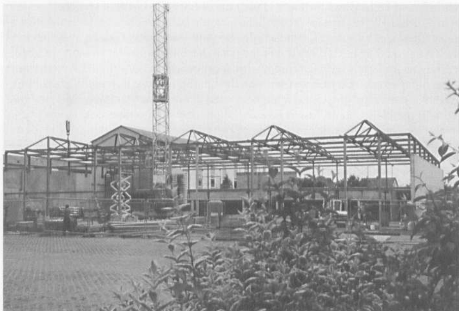
Nach einem viertel Jahr Bauzeit nimmt die Sporthalle Konturen an
