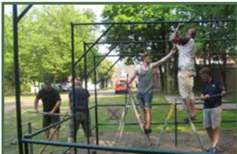
Aufbauen des Schießunterstandes und der Absperrung
