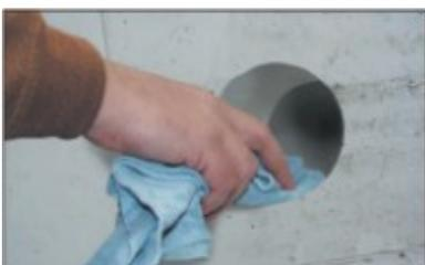
Entstauben der Kernbohrung
