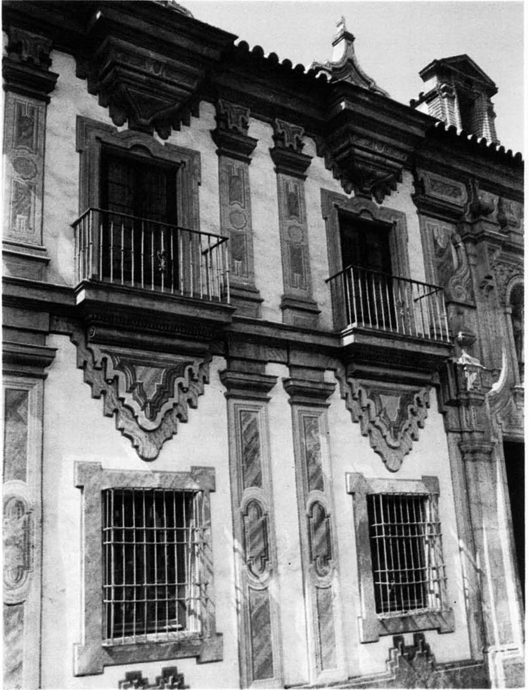
DETALLE FACHADA DEL PALACIO DE LA MERCED
