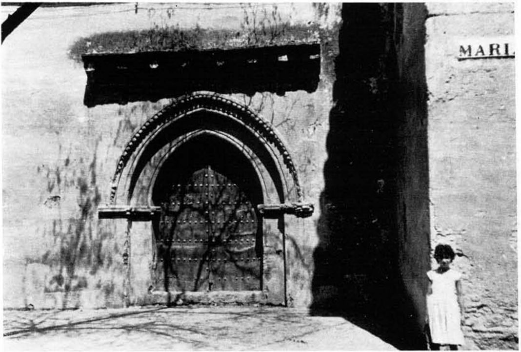
PUERTA DE LA NAVE DE LA EPISTOLA
