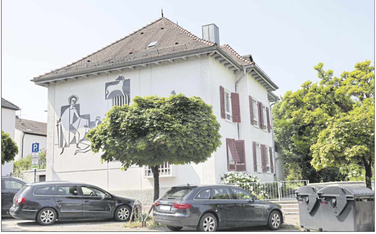
Das ehemalige Klösterle wird abgebrochen.
