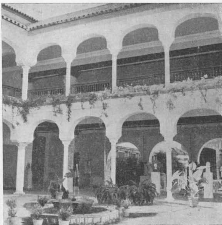
Patio principal del Palacio obra debida al maestro cantero Hernán Ruiz II.
