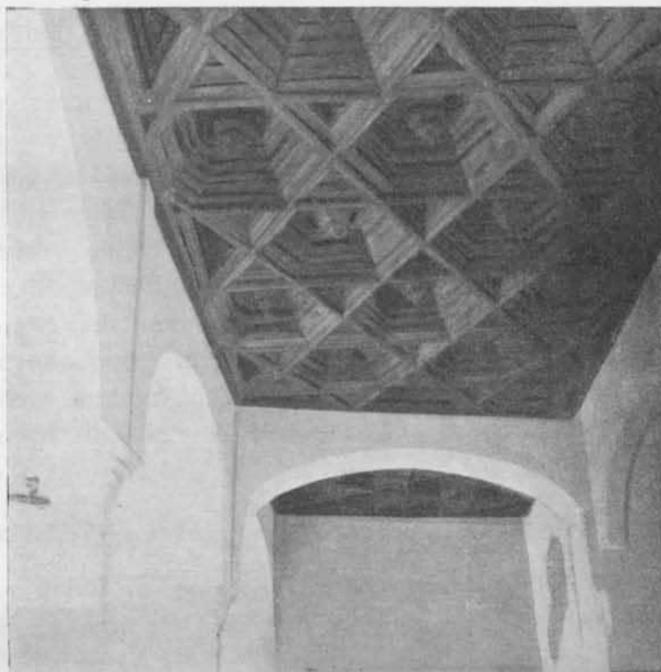
Artesonado de una de las galerías bajas del Palacio, construido cuando era su propietario D. Jerónimo Páez de Castillejo, modernamente restaurada.
