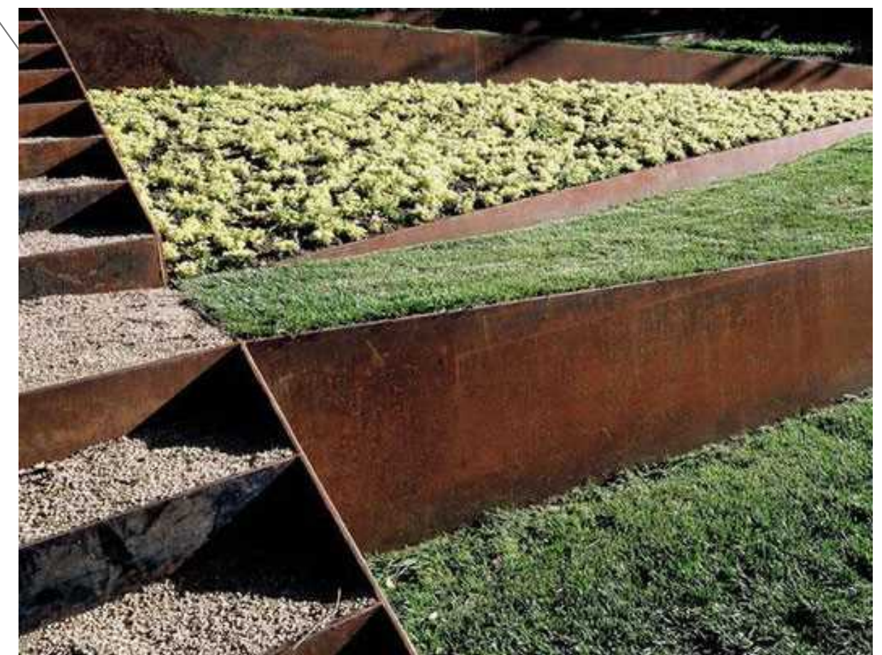
Erdstützwand Cortenstahl
