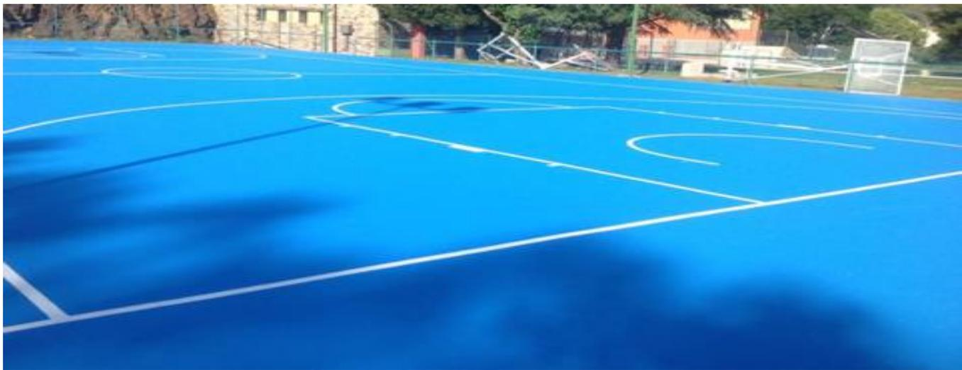
Recubrimiento acrílico de medio espesor con textura de acabado semi rugosa antideslizante para solicitudes mecánicas bajas-medias.
