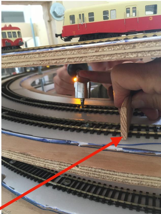
Un gabarit exécuté par Michel permet de s'assurer du respect de l'écart et du parallélisme des rails.
