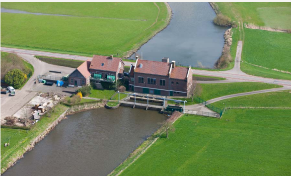
Gemaal Terwolde, bron: Waterschap Vallei & Veluwe
