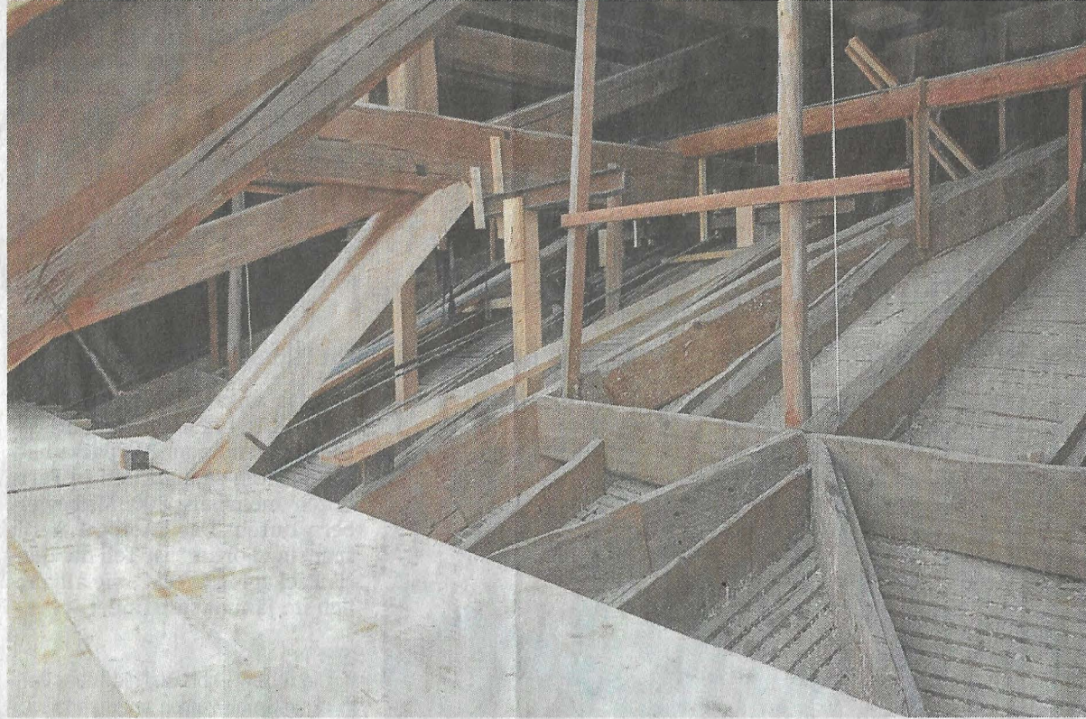
Blick in die Gewölbeebene des Dachtragwerks nach der Instandsetzung des Knotenpunkts.
