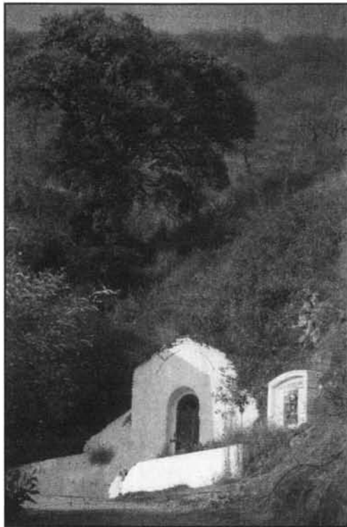
LÁM. V. Entrada al aljibe de Daimalos.
