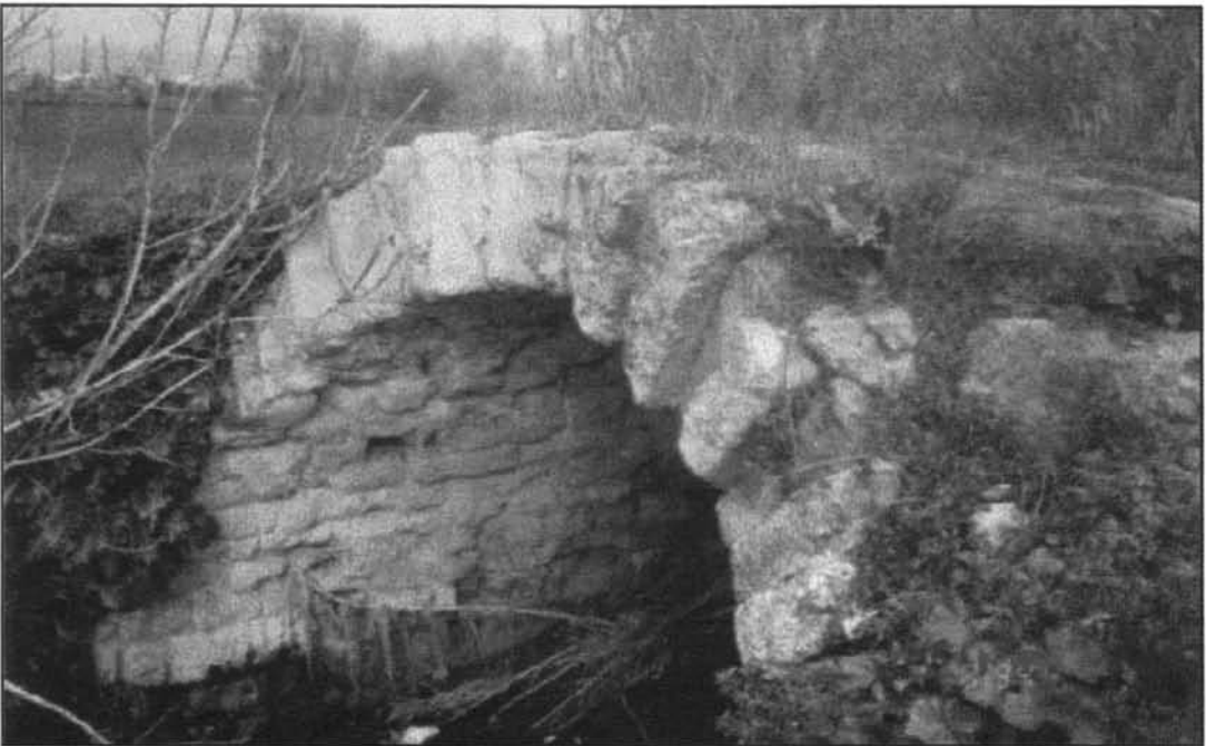
Puente califal en El Alcaide (Dar al-Na'ura )
