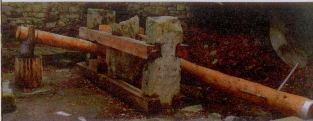
Sul tronco principale del maglio, dove sono inseriti tre manici per simulare il movimento, c'erano le pale per l'acqua.
