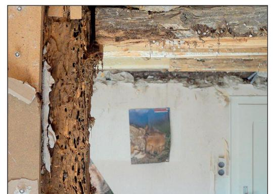
Die kläglichen Reste eines über 250 Jahre alten Türbalkens nach Entfernen der intakten Außenverkleidung.
