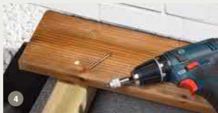
4 Terrassendielen im rechten Winkel zur Unterkonstruktion ausrichten. Bitte achten Sie auf ausreichend Abstand zu festen Bauteilen wie Wänden. Es sind zwei Verschraubungen je Brettbreite pro Kreuzpunkt mit der Unterkonstruktion erforderlich. Wir empfehlen Ihnen, vor dem Schrauben mit einem Bohrer mit Senker vorzubohren.
