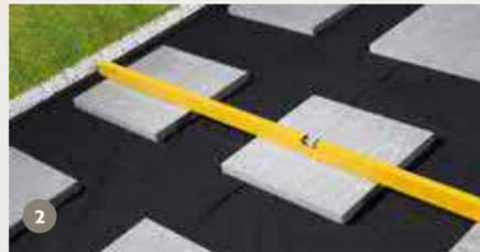
2 Jetzt Stein- oder Gehwegplatten verlegen. Der Abstand der Platten muss entsprechend dem zukünftigen Abstand der Unterkonstruktion gewählt werden. Bitte kontrollieren Sie nochmals das Gefälle.
