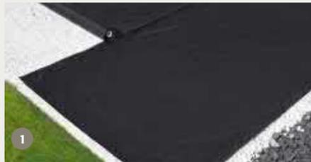
1 Als ersten Schritt legen Sie eine ebene Fläche an. Anschließend wird eine grobe Schotter- (20-40 cm) und eine anschließende Kiesschicht (5 cm) auf der Fläche verdichtet. Bitte beachten Sie, dass die Fläche ein Gefälle von ca. 1-2 % haben muss. Es wird empfohlen, zusätzlich ein Unkrautvlies als Schutz zu verlegen.
