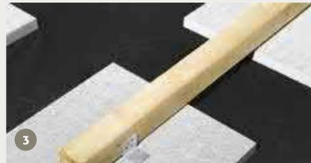
3 Unterkonstruktion hochkant und mittig auf die Steinplatten legen und an mindestens drei Punkten mit Metallwinkeln befestigen. Je nach Holzart und Stärke der Terrassendiele sollte der Abstand der Unterkonstruktion zwischen 20 und max. 50 cm liegen.
