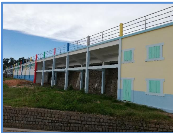
Nouveau gradin ouest du terrain de foot
