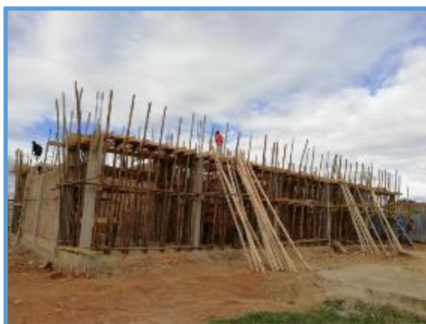
Nouvelle construction d'un Lycée à Mahatsara
