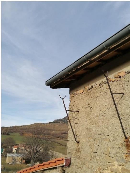
Une dégradation de la **gouttière Nord - Ouest de l'église du Castellard** a été constatée, une reprise de gouttières à l'arrière de l'église sur 50 cm a été réalisée, à cette occasion le contrôle de la section avec la reprise de certaines soudures ont été faites.
