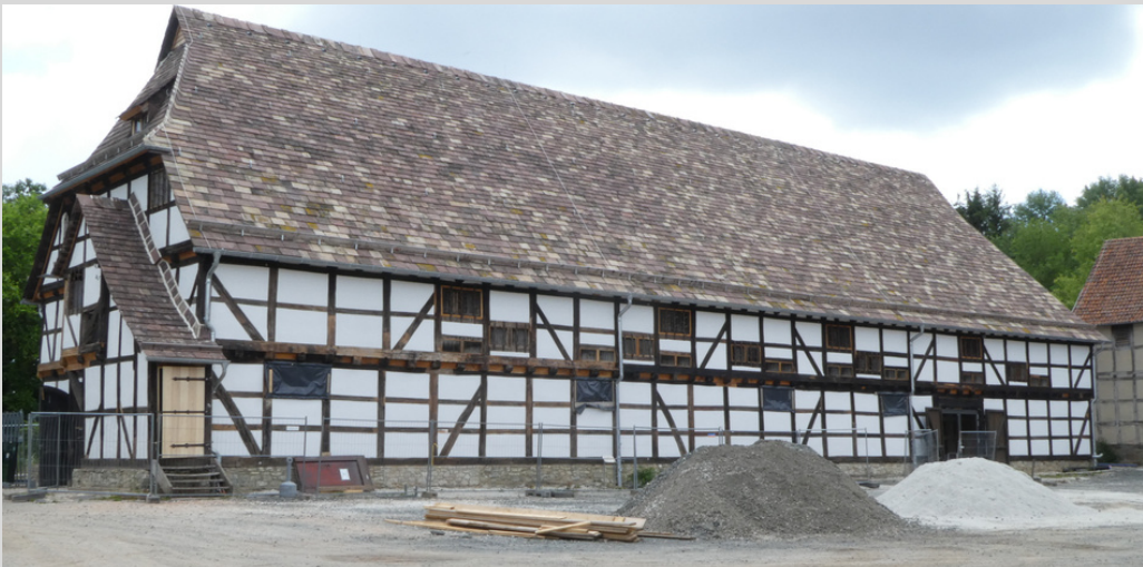
Dacherneuerung am Fruchtspeicher im Hessenpark
