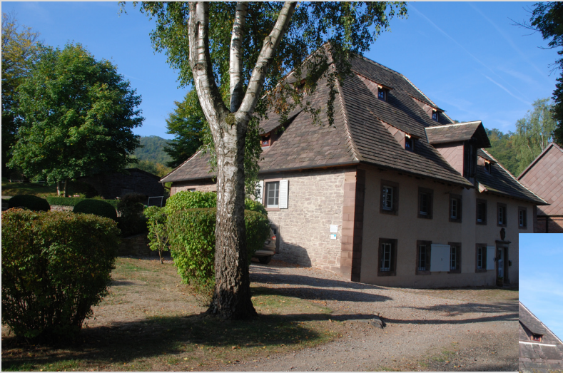
Dacherneuerung Gebäudeensemble der Duhne Mühle
