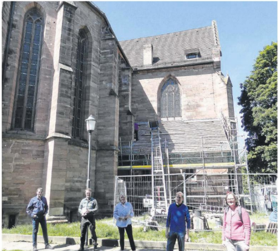
Architekt Tim Wameling, Bauleiter Mathias Riethmüller, beide von der Klosterkammer, Heike Dörries-Timmermann, Chefin der Dachdecker-Firma, Peter Bucher, Plattenmacher, und Pastorin Dr. Wiebke Köhler vor der Baustelle an der Münsterkirche.
