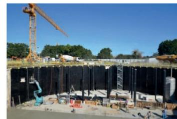
AGRUSAFE Betonschutzplatten schützen die Ortbetonwände der Klärbecken zuverlässig vor Korrosion durch Schwefelwasserstoffgas
