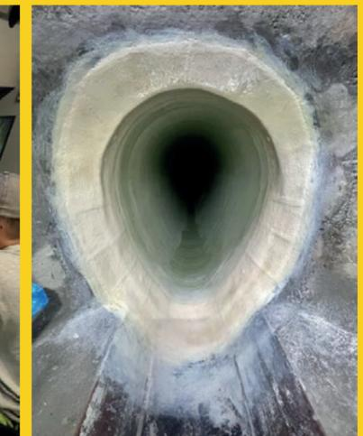
Einbindung mit GFK-Laminat
