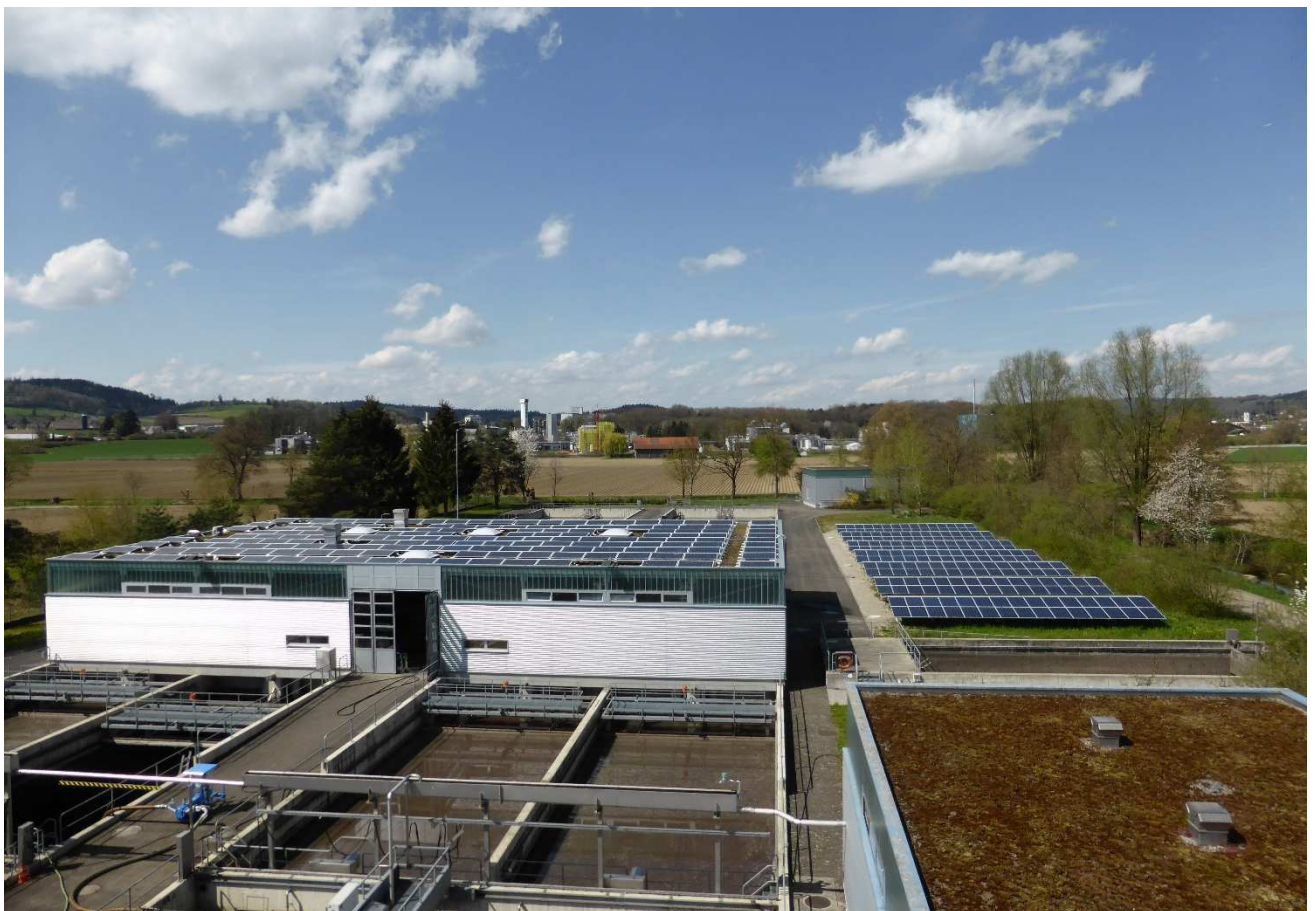
Sicht auf die Module der Photovoltaikanlage auf dem Dach des Maschinenhauses und auf der Wiese
