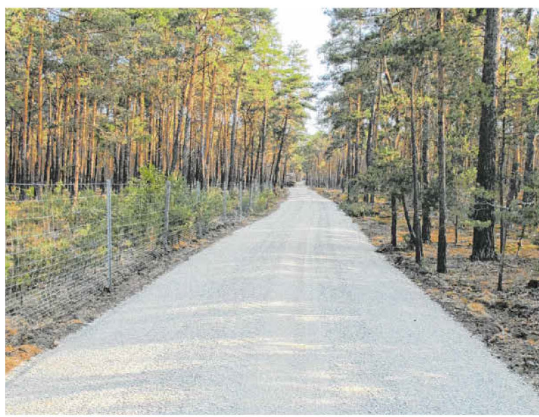
In der Gemeinde Heideblick werden Waldwege als Waldbrandschutzwege ausgebaut, so wie auch hier im Schliebener Bereich.
