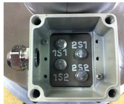
Рисунок 9. Пример кабельной коробки и шильда трансформатора тока с двумя сердечниками
