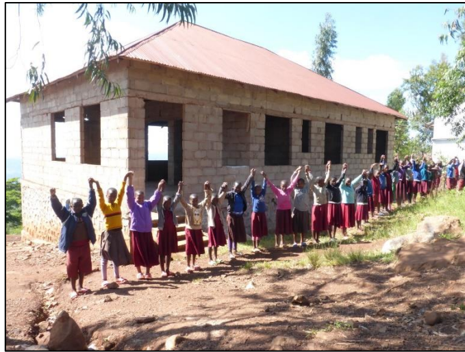
Gästehaus im Rohbau
