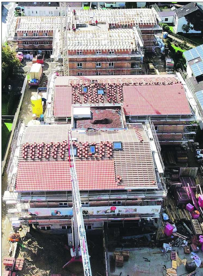
Die Bauarbeiten gehen zügig voran.
