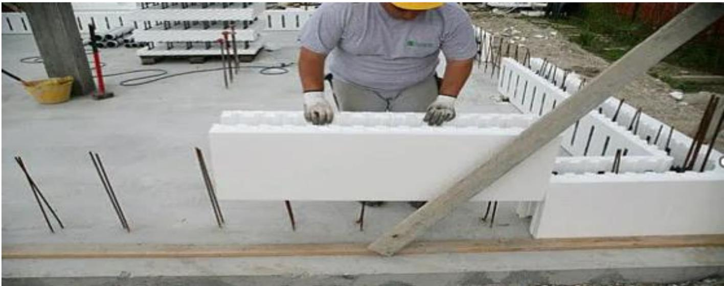
Piscina térmica de bloque de Poliestireno Expandido EPS, relleno de hormigón con armadura vertical y horizontal atada, conformando una estructura totalmente autoportante.
