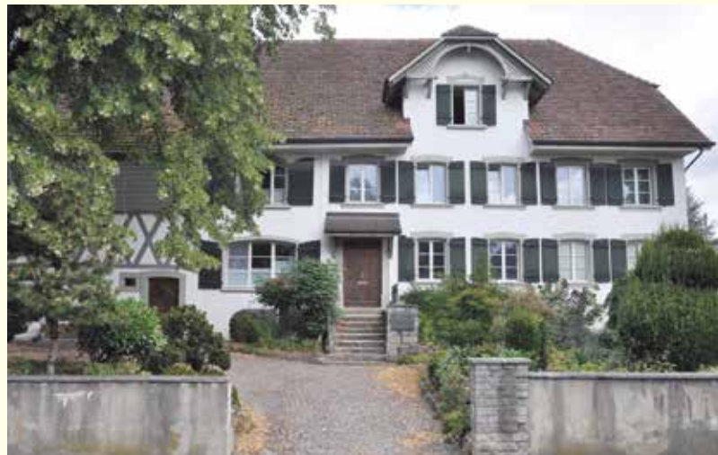
Das alte Pfarrhaus mit dem Atelier in der ehemaligen Scheune.
