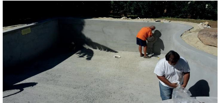
Miscelare con acqua **DECOR STONE POOL**, eventualmente aggiungendo il toner colorante liquido. Saturare con acqua le superfici precedentemente preparate ed applicare un primo strato di prodotto con cazzuola o frattazzo. Per garantire una corretta impermeabilità della finitura, applicare uno spessore di almeno 1,5 mm, equivalenti a circa 3 kg/m<sup>2</sup>.
