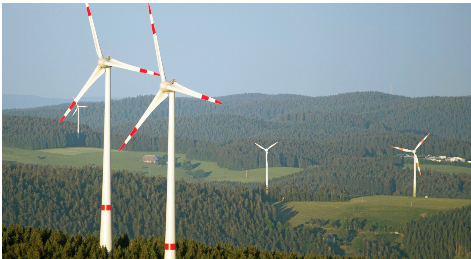
Die heutzutage geplanten Windräder werden immer höher, die Anlagen bei Oedingen sollen eine Gesamthöhe von 240 Metern haben. FOTO: PATRICK SEEGER
