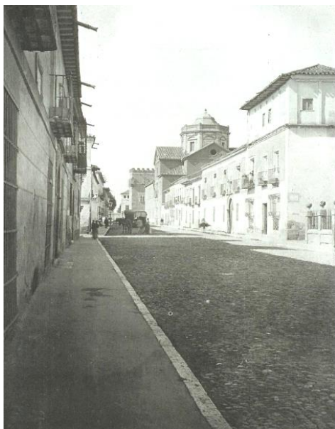
Calle de Santiago con sus aceras recién estrenadas de asfalto Siglo XIX. Tomado de Memoria Gráfica de Alcalá (1860-1970). Al fondo a la izquierda la casa del alcalde Palou. Con licencia del autor.
