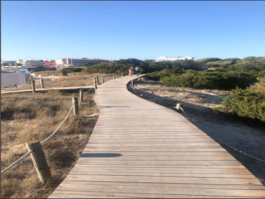
Foto 30. Pasarela de protección y cordaje para impedir el acceso a las dunas. Es Pujols al fondo. Fotografía del autor.
