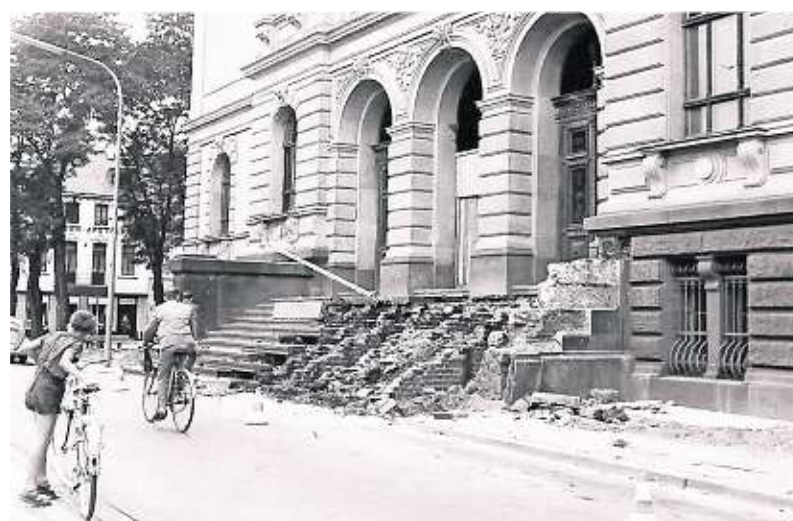
Tiefer Eingriff ins Gebäude: 1966 wird die Freitreppe abgerissen. Unten wurde ein Eingang geschaffen, innen neue Flächen gewonnen. FOTO: KARL HEINZ LENGWENINGS
