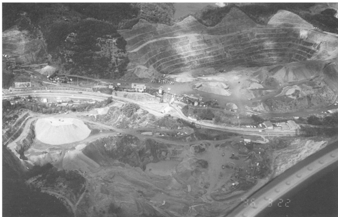
▲愛岐処分場全景
