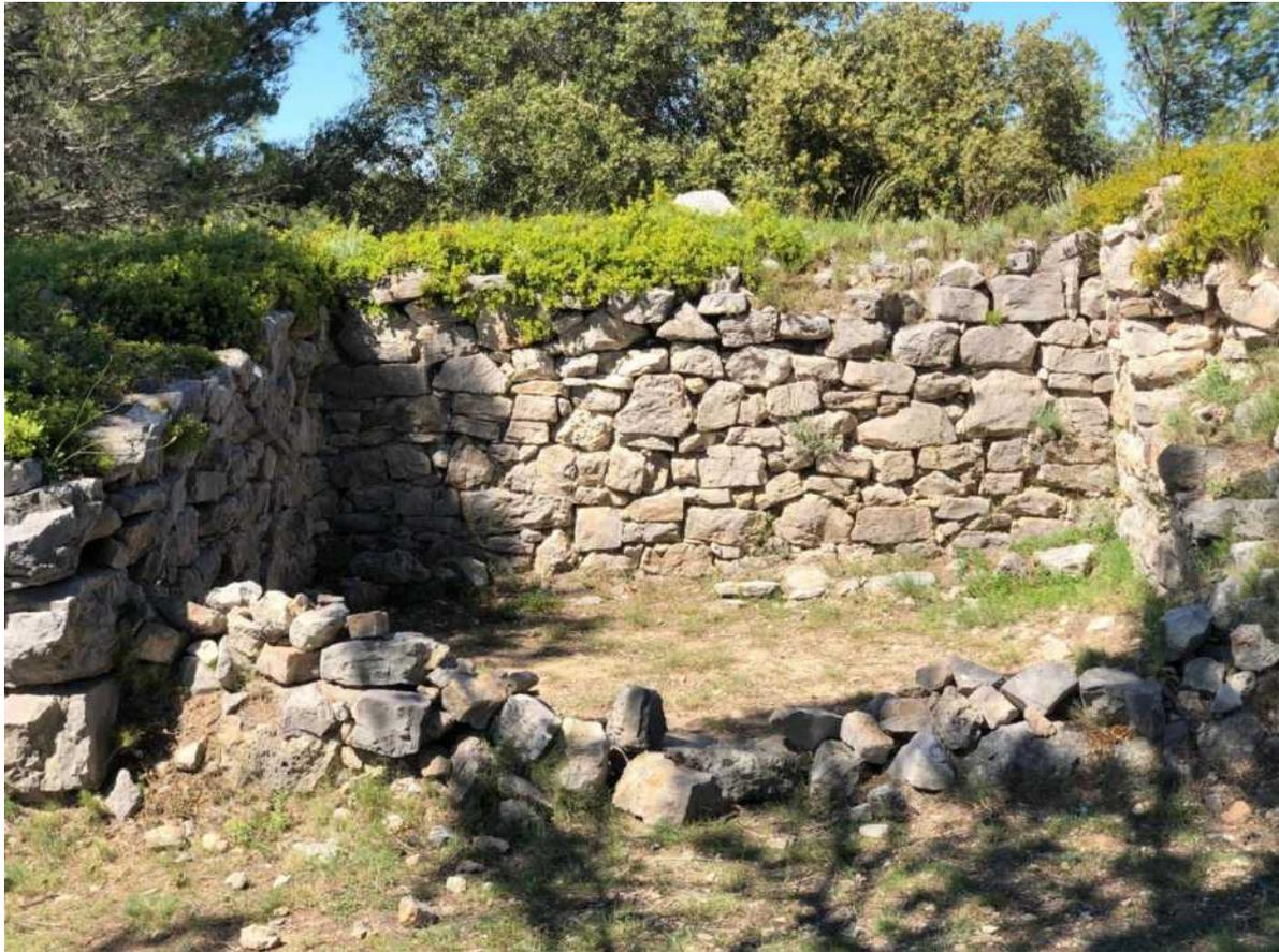
**Habitat adossé au mur d'enceinte et ci-dessous l'emplacement d'une tour d'angle qui permet de voir l'existence d'une porte qui a été condamnée pour y construire une habitation et ce qu'on appelle un « chantepleur » un trou dans le mur qui permet l'évacuation des eaux pluviales.**
