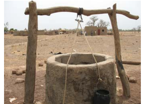
Réfection du puits
