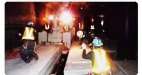
ホーム床の設置
