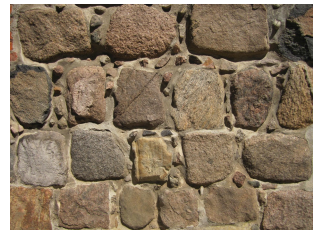
Abb.5 Mauer aus behauenen Feldsteinen vor 1240
