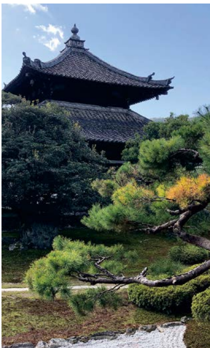
鹿王院の舎利殿（現在修復中）。 中に源実朝が宋から招来した仏牙舎利（釈 尊の歯）を安置する多宝塔がある。
