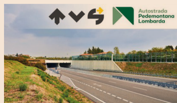
Autostrada Pedemontana Lombarda
