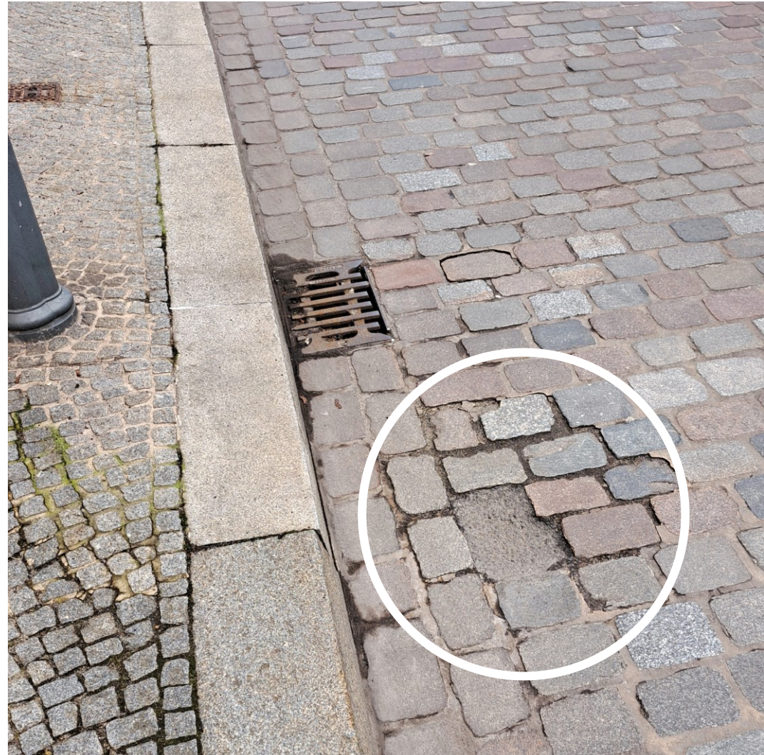
Stelle nach Ausbesserung am 20.02.2023
