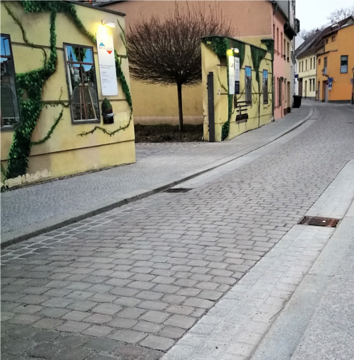
Straßenzustand Wollenweberstraße am 09.03.2021 Gutes Fugenbild mit ausreichender Fugenfüllung
