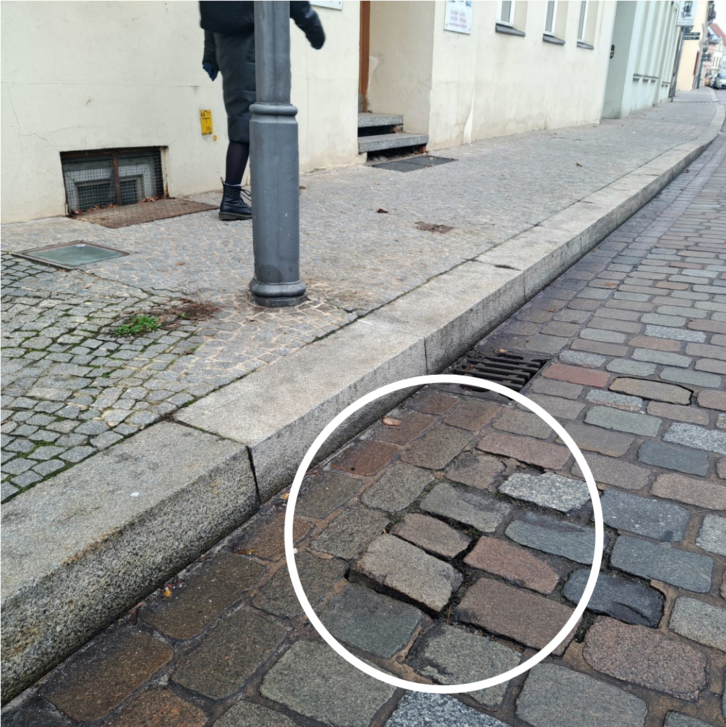
Neue Schadstelle am 10.12.2022
