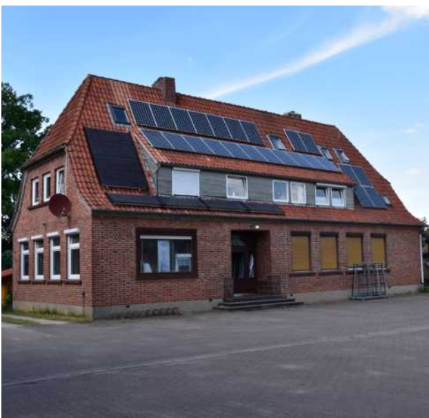
Abb. 55 Solaranlagen in Toppenstedt
