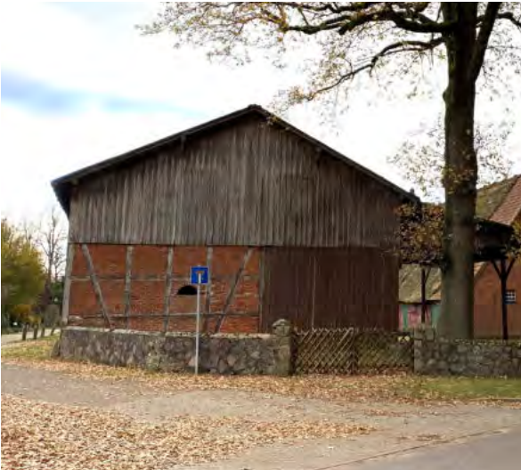
Abb. 26 Holzverschalung am Nebengebäude
