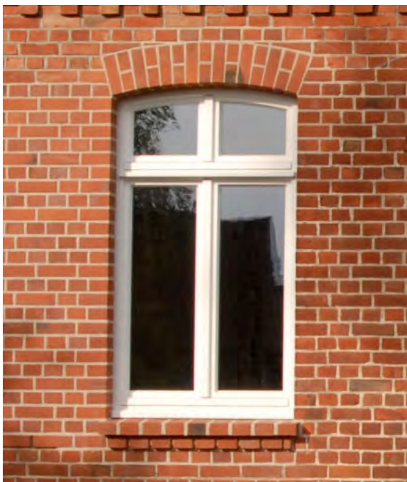
Abb. 33 Beispiel Zweiflügeliges weißes Fenster mit Oberlicht (um 1900)
