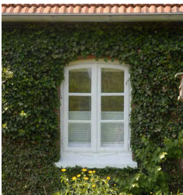
Abb. 30 Beispiel üppige Fassadenbegrünung
