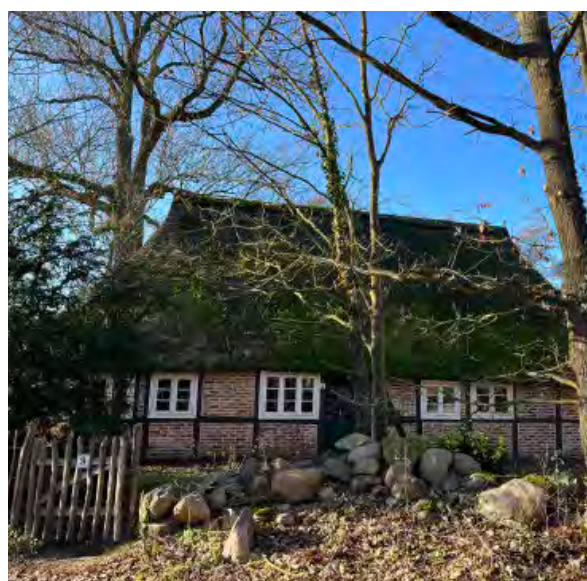
Abb. 3 Einfriedung Staketenzaun mit Steinwall
