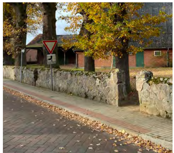
Abb. 44 Einfriedung aus Naturstein, mit in Mörtel gesetzten behauenen Natursteinen
