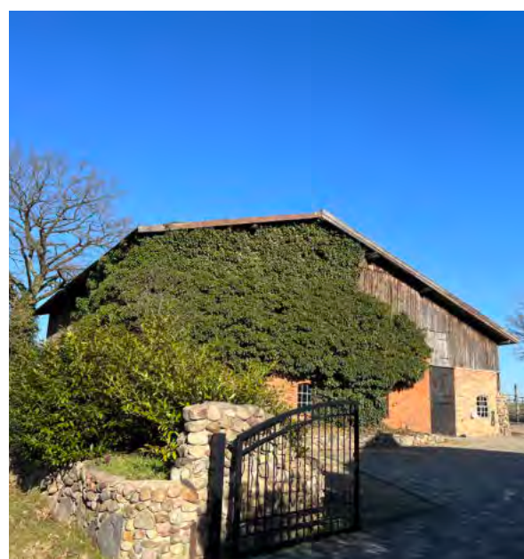
Abb. 31 Beispiel üppige Fassadenbegrünung einer Scheune
