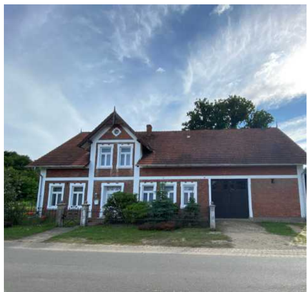
Abb. 47 Wohngebäude in Wulfsen
