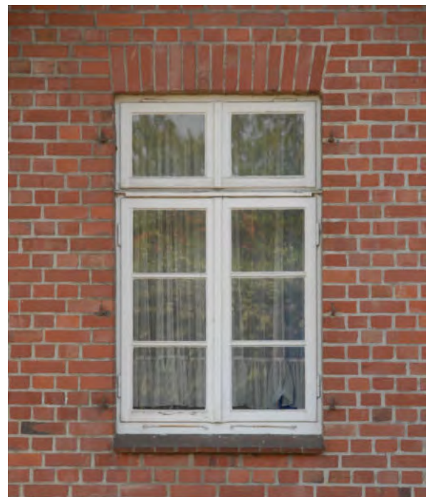
Abb. 34 Beispiel Fenster mit einfacher Sohlbank
