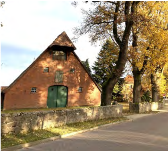
Abb. 13 Wohnwirtschaftsgebäude mit Kranch im Giebel
