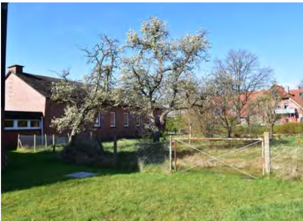
Abb. 102 Revitalisierung Gemeindehaus Toppenstedt
