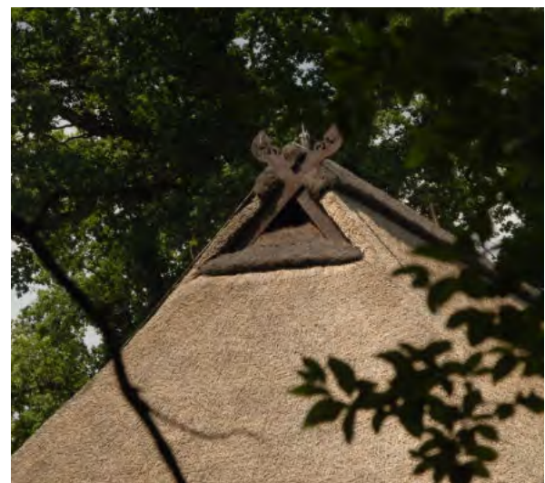
Abb. 24 Beispiel eines Eulenlochs
