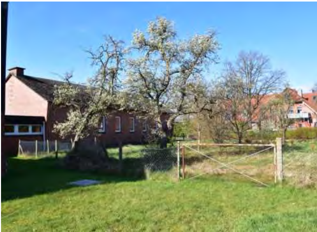
Abb. 77 Revitalisierung Gemeindehaus Toppenstedt
