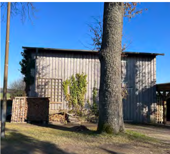
Abb. 27 Beispiel für Holzverschalung am Nebengebäude
