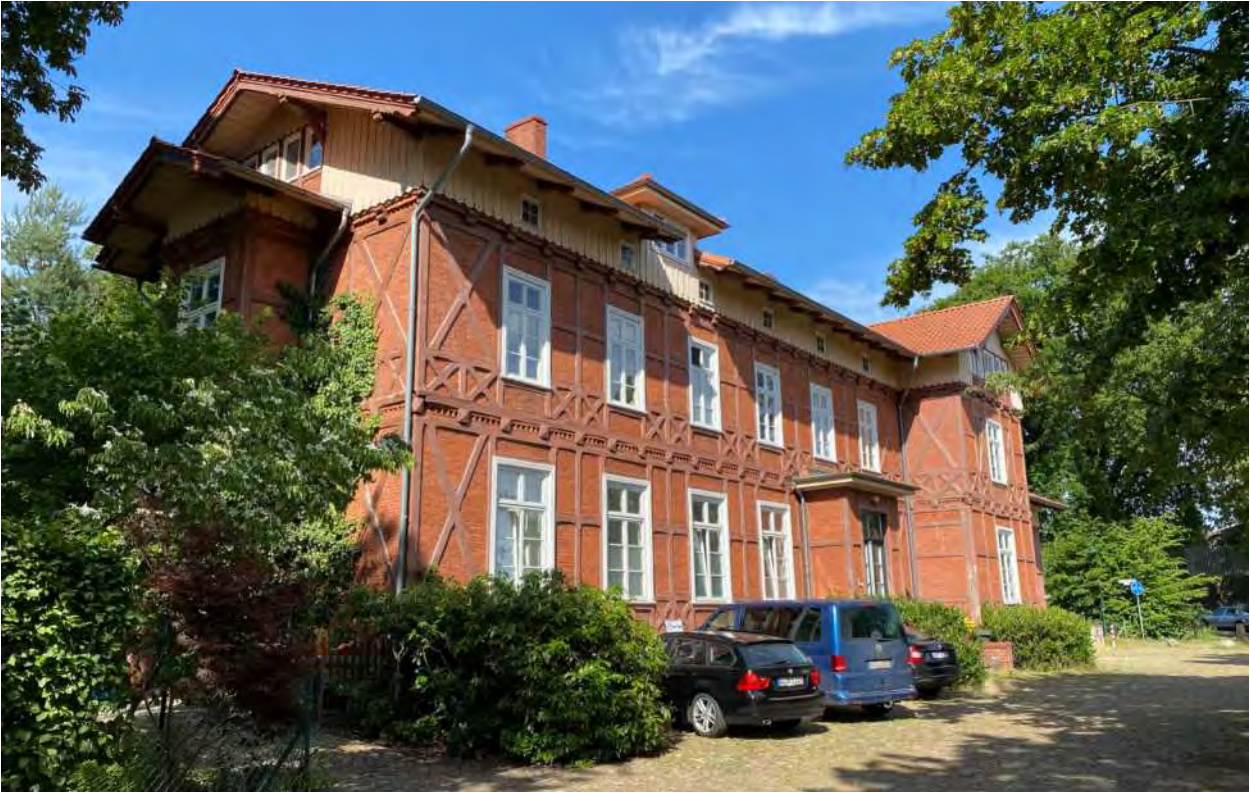
Abb. 126 Wohnen im ehemaligen Bahnhofsgelände
