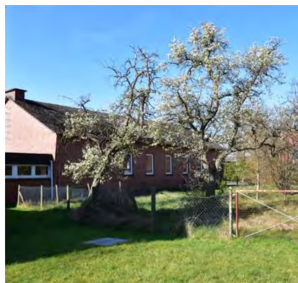
Abb. 40 Revitalisierung Gemeindehaus Toppenstedt
