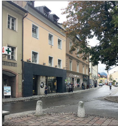
Die Häuser Muchargasse 15, in früherer Zeit Sitz des Lienzer Bergrichters und daneben Muchargasse 17, das ehemalige Berggerichtsdiennerhaus. Foto: Meinrad Pizzinini
