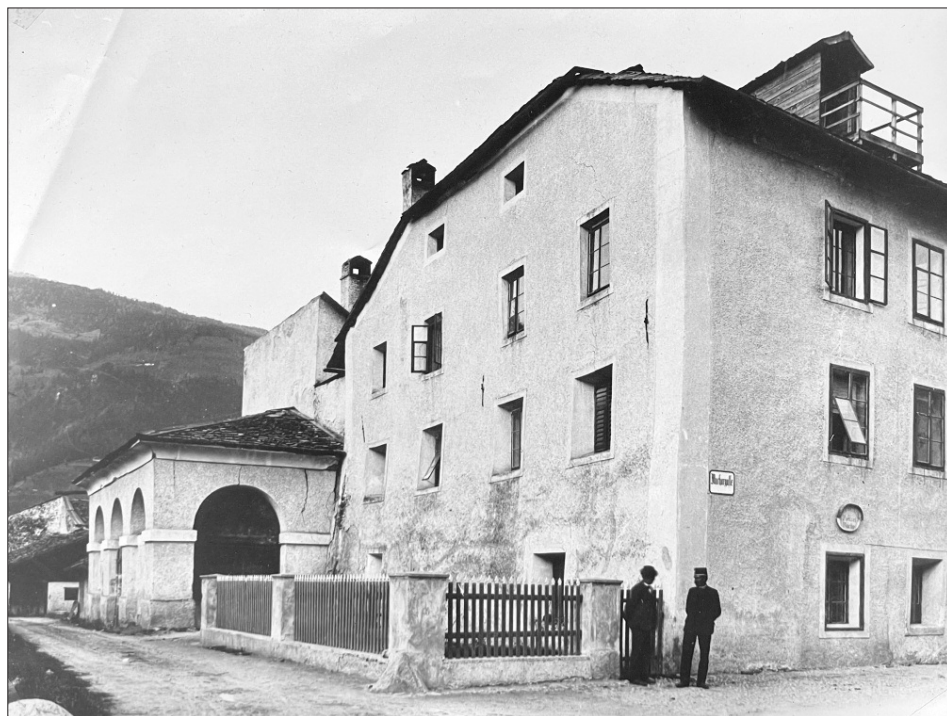
Das „Tesser-Haus“ aus südwestlicher Richtung, um 1890; wenige Jahre später musste es dem Neubau des „Buben-Schulhauses“ weichen; die Schule wurde im Oktober 1904 eingeweiht und in Betrieb genommen. (Foto: Georg Egger; Fotoarchiv Dr. Meinrad Pizzinini)
