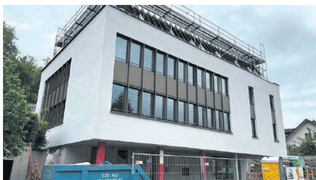
Die Arbeiten am erweiterten und sanierten Gemeindehaus befinden sich in der Schlussphase.
