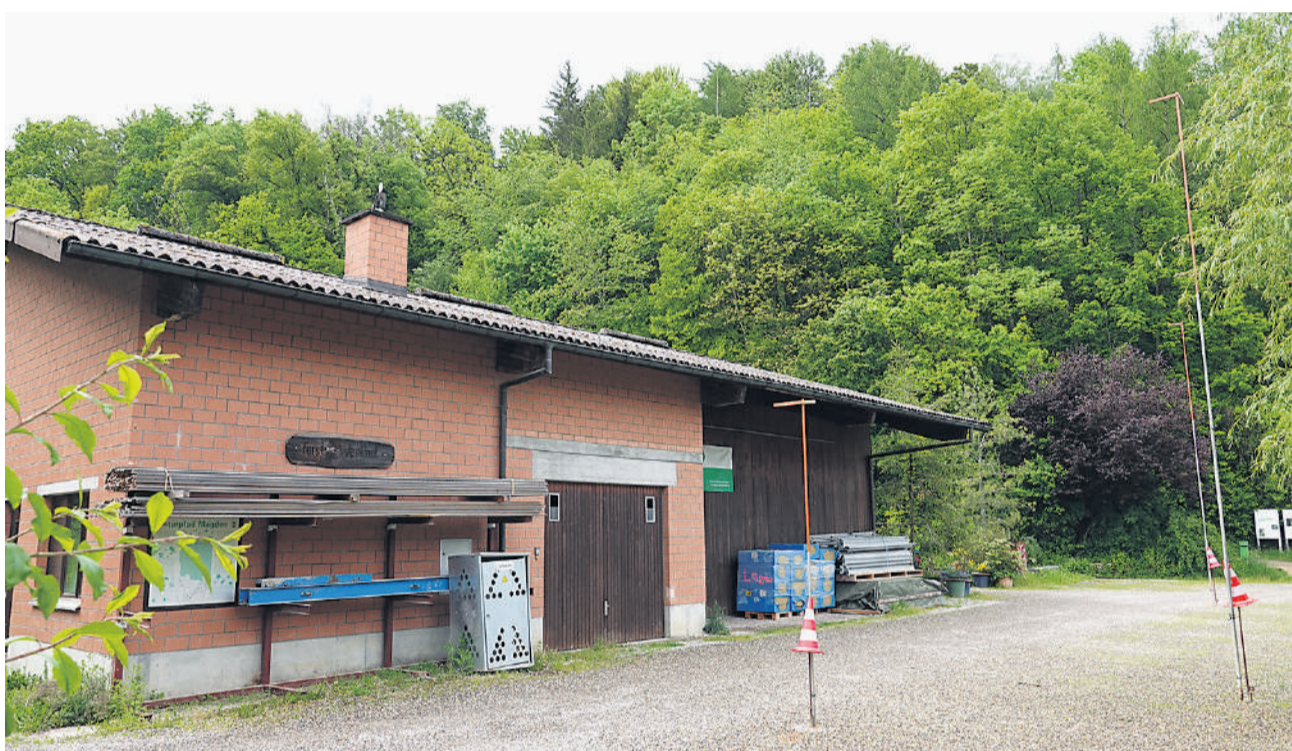
Der alte Forstwerkhof soll zurückgebaut werden. An seiner Stelle ist ein Asylzentrum in Modulbauweise geplant. Die Bauprofile stehen bereits.
