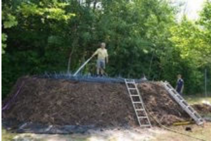
Biomeiler klassischer Aufbau 120m 3 , 8m Durchmesser, 2,2m hoch, Wärmetauscherrohr auf Baustahlmatte
