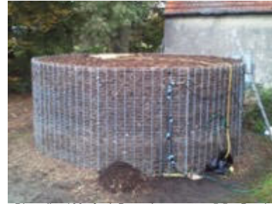
Biomeiler 100m 3 mit Doppelstegmatten 5,5m Durchm. 2,5m hoch Rohrführung außerhalb des Grünschnitts
