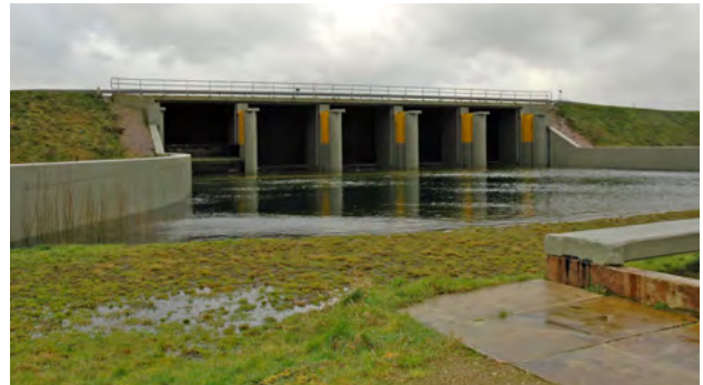
Inlaatwerk in het dijklichaam ter hoogte van landgoed 'De Haere'. (Foto: IJssellinie.nl)
