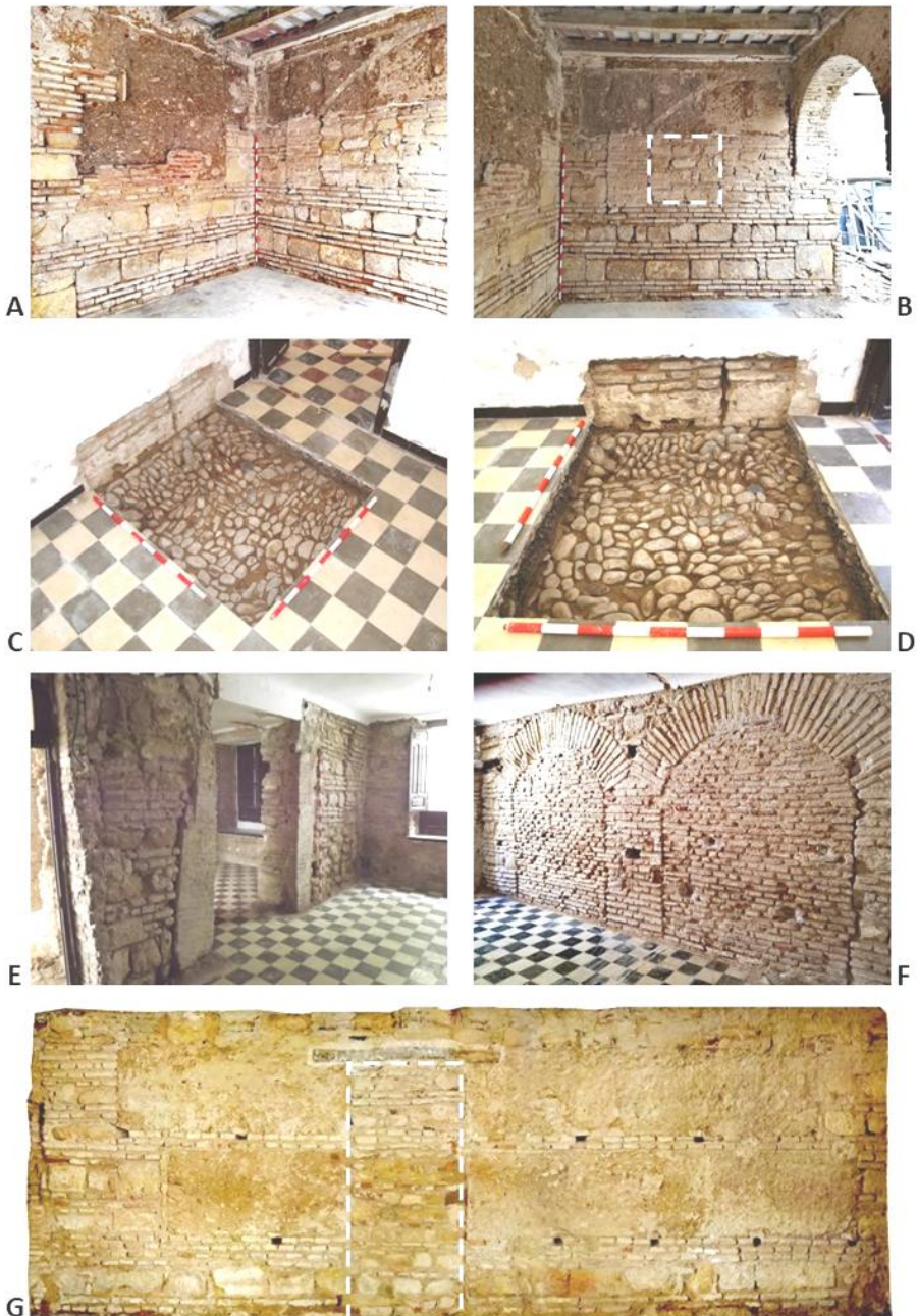
Figura 4. A. Esquina original en Calleja de las Flores. B. Detalle del Muro 84, con indicación de una posible ventana. C y D. Detalle del pavimento del adarve documentado en la zona sur de Calle Encarnación. E, F y G. Diferentes entradas que dan acceso a diferentes viviendas desde el adarve documentado en la zona sur de Calle Encarnación
