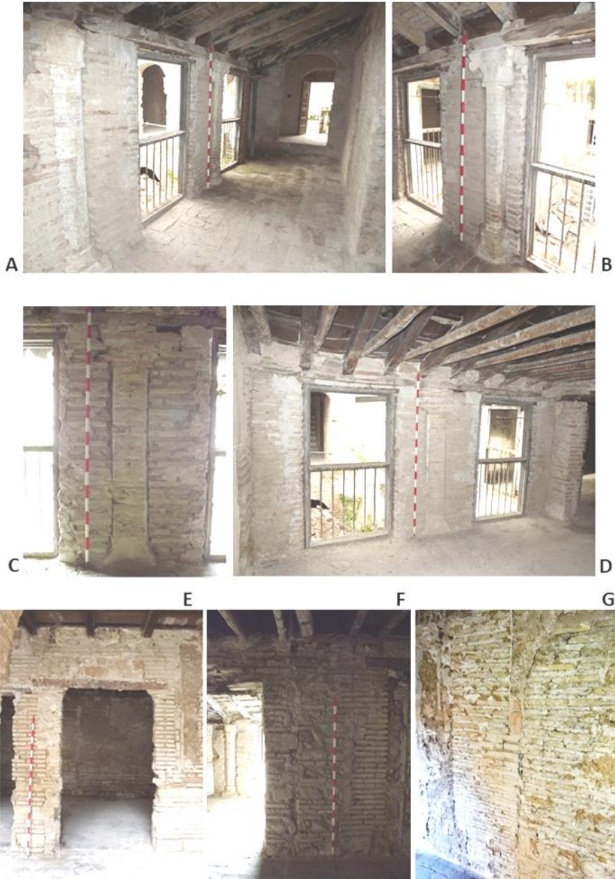
Figura 6. A, B, C y D. Galería mudéjar de Calleja de las Flores, primera planta. F, G y H. Detalle de los vanos mudéjares que dan acceso a la crujía norte desde la galería de Calleja de las Flores
