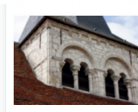
Le beffroi (charpente)
